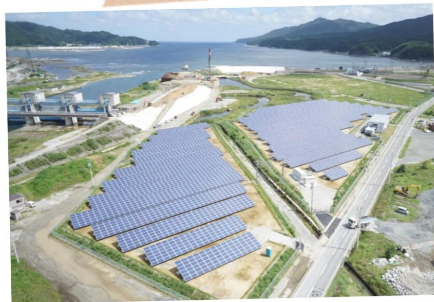
津軽石太陽光発電所
