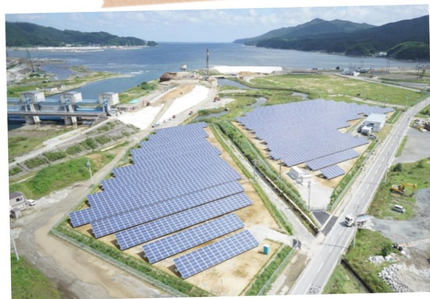
津軽石太陽光発電所
