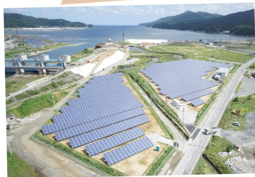
津軽石太陽光発電所
