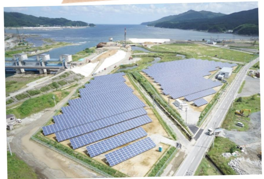
津軽石太陽光発電所
