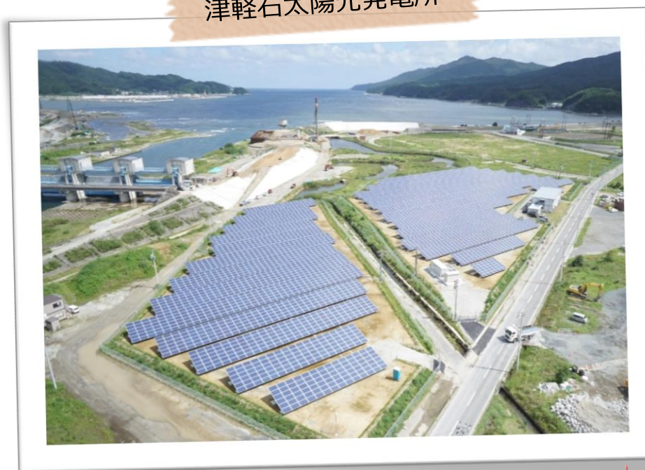
津軽石太陽光発電所
