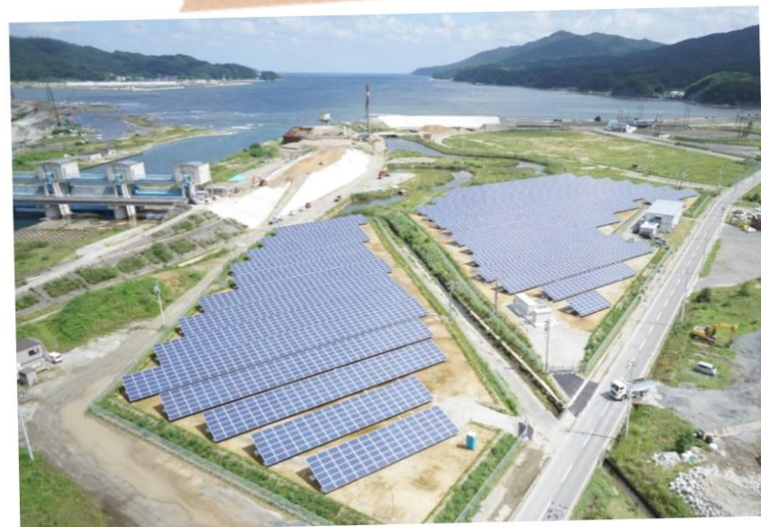
津軽石太陽光発電所
