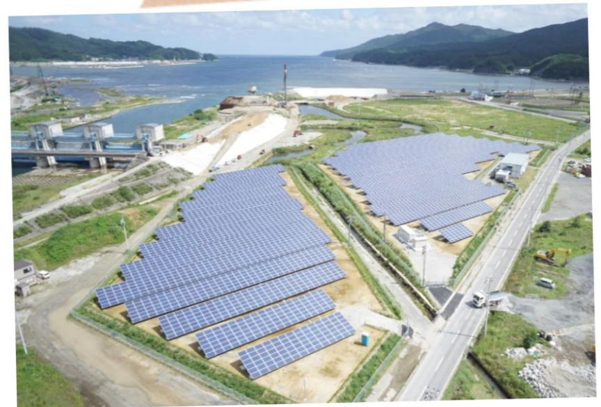
津軽石太陽光発電所
