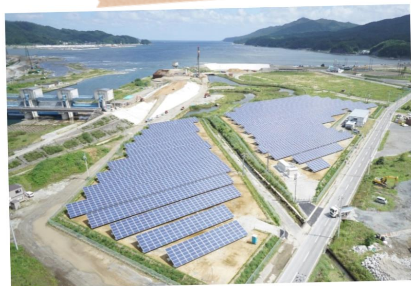
津軽石太陽光発電所
