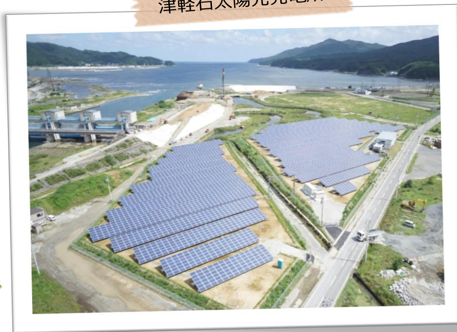
津軽石太陽光発電所
