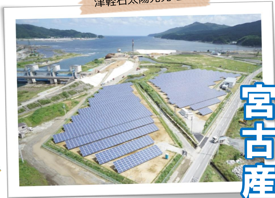
津軽石太陽光発電所
