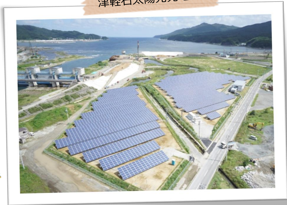
津軽石太陽光発電所
