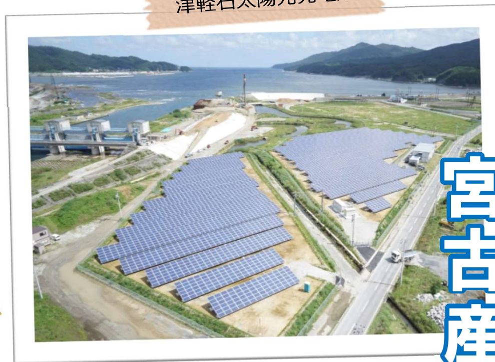
津軽石太陽光発電所
