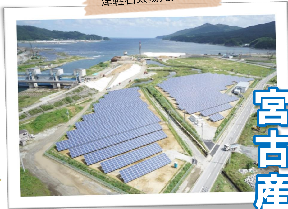
津軽石太陽光発電所
