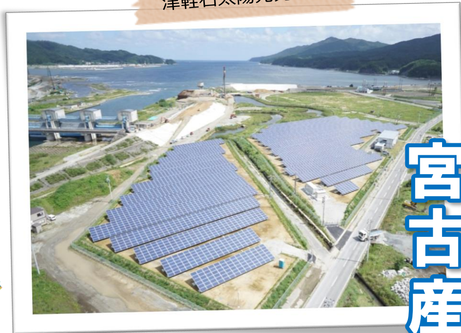
津軽石太陽光発電所
