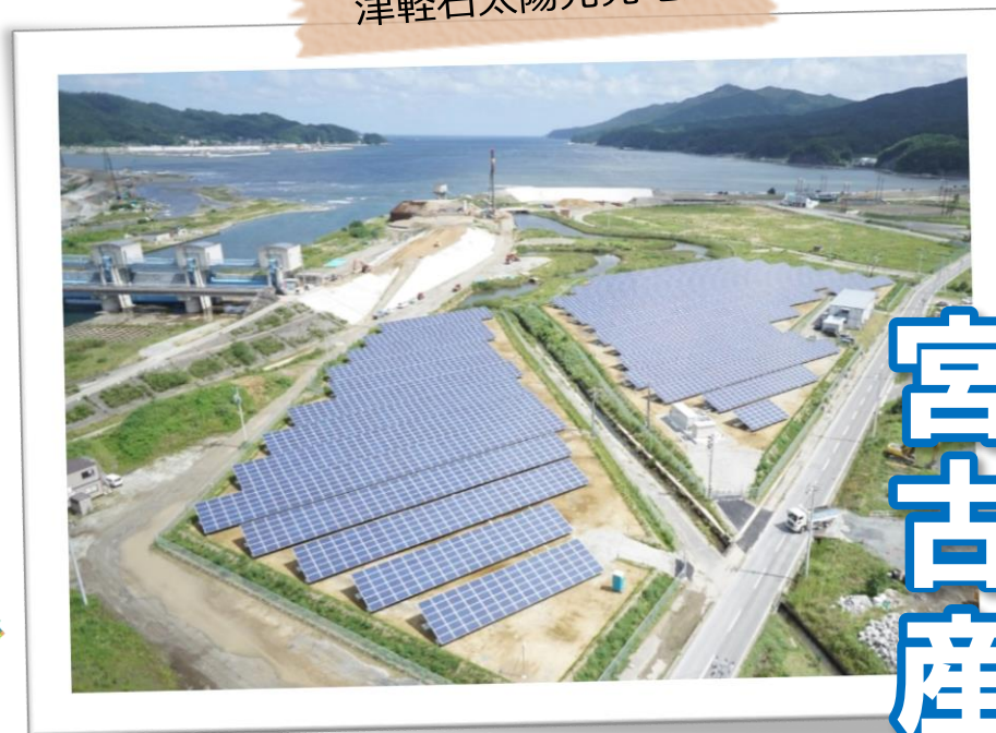
津軽石太陽光発電所
