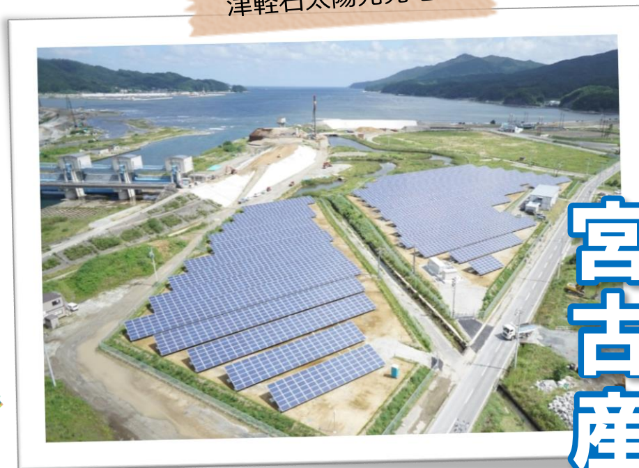
津軽石太陽光発電所
