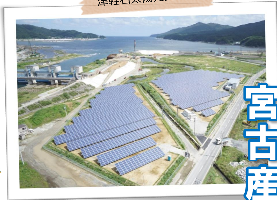
津軽石太陽光発電所
