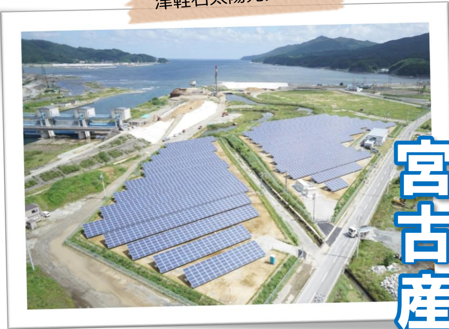
津軽石太陽光発電所
