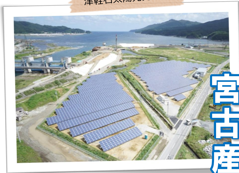
津軽石太陽光発電所
