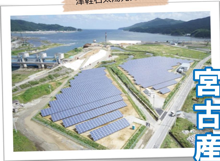
津軽石太陽光発電所
