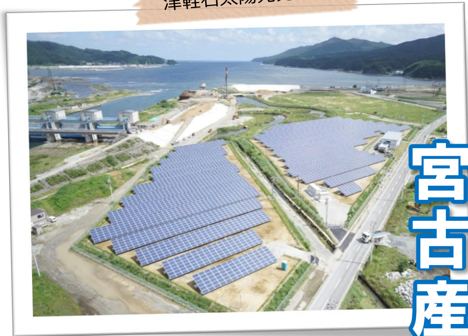
津軽石太陽光発電所
