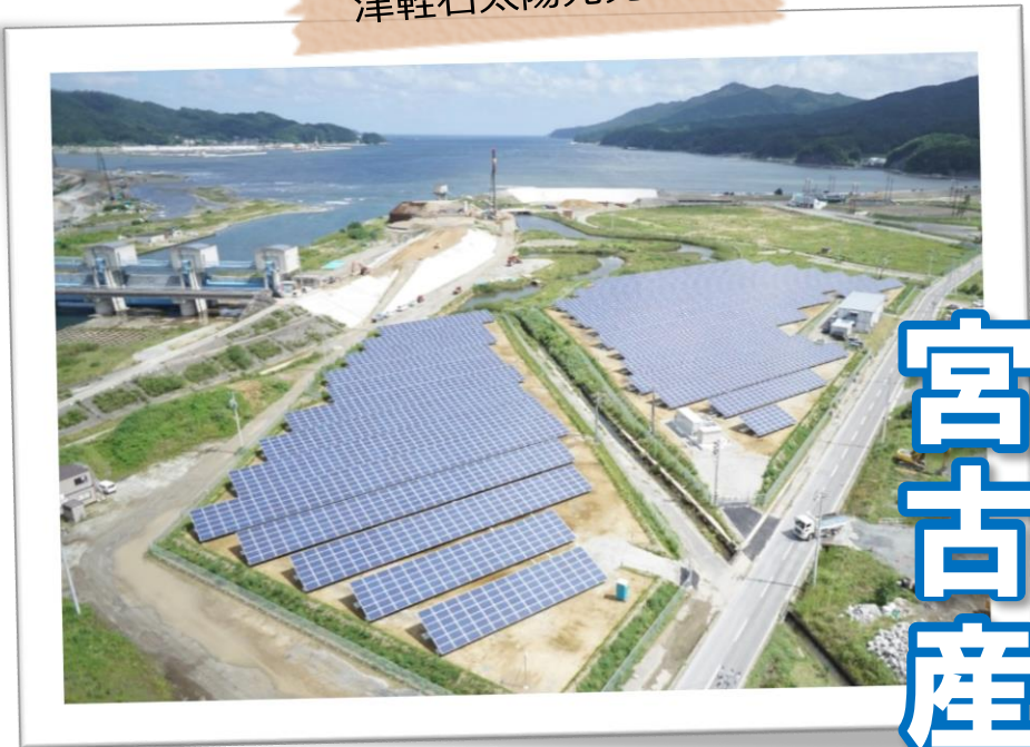
津軽石太陽光発電所
