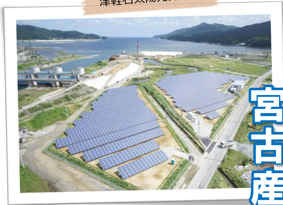
津軽石太陽光発電所
